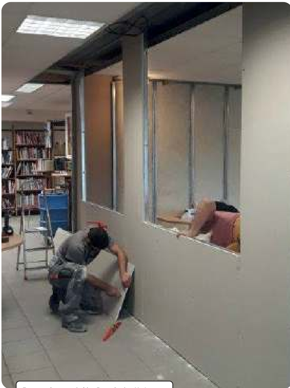
Travaux aménagement intérieur France Services Maubourguet
